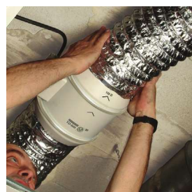
Collegamento ai condotti.
